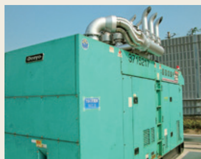
常用発電機 (610kVA) /モコキューブCTE12
