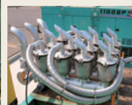
常用発電機 (610kVA) /モコキューブCTE12
